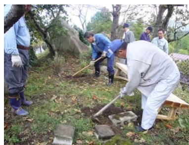
ベンチ据え付け作業
